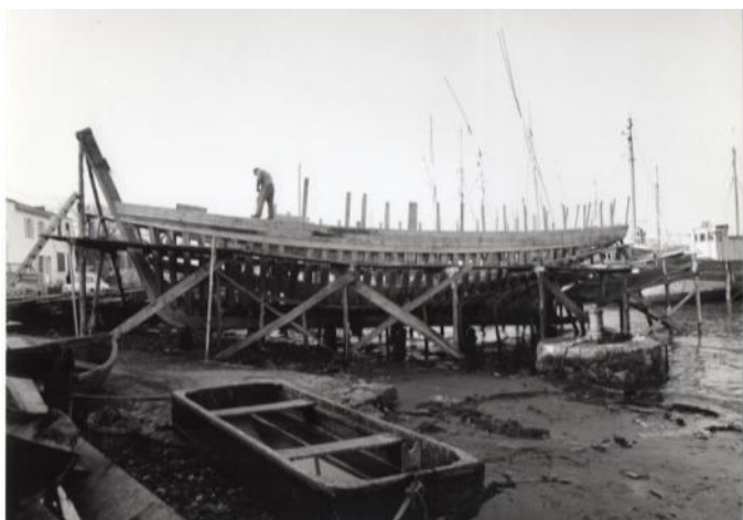
Un thonier en construction aux ateliers Barranger. Au premier plan, une "plate" pour peindre les bateaux. Photo Roger Turbé Coll Barranger
