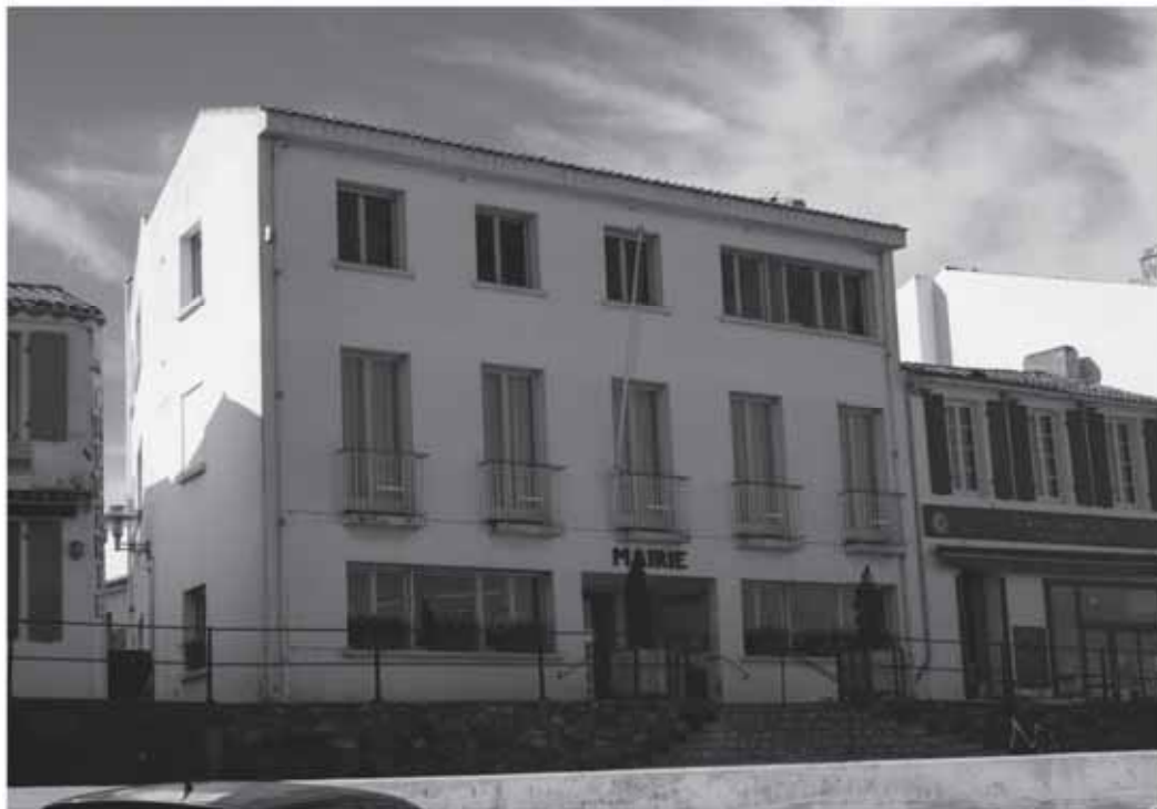
La mairie va faire l'objet de travaux de rénovation et d'agrandissement
