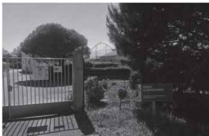
Des travaux de mise aux normes sont prévus à la station d'épuration
