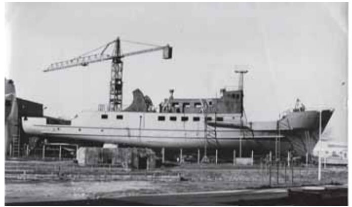
La Vendée en construction sur la cale des chantiers de La Perrière à Lorient. On remarquera à l'avant, un pousseur d'étrave pour virer plus facilement. Photo Gérard Turbé.
