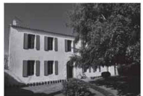
Le presbytère du Port nécessite d'importants travaux de réfection et de mise aux normes
