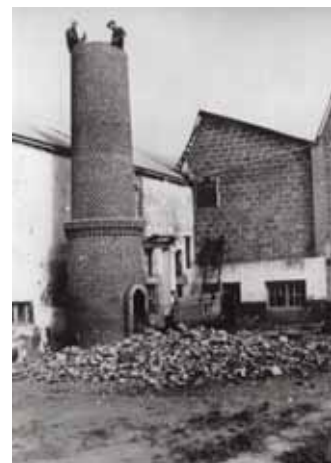
Démolition de la cheminée de l'usine Béziers - La Mouette riieuse » Abbé Ratte éditions Aéropage, 23 rue de la Comédie - 39 000 Lons-le-Saulnier.
