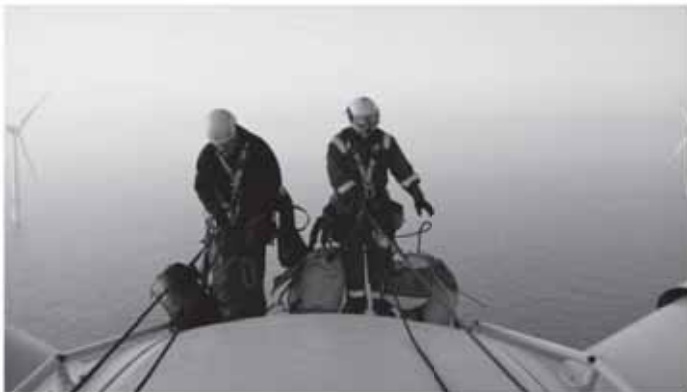
Opération de maintenance sur une éolienne offshore (Crédit : Adwen)
