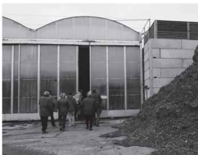
Les biodômes servent à la fermentation et la macération des déchets verts
