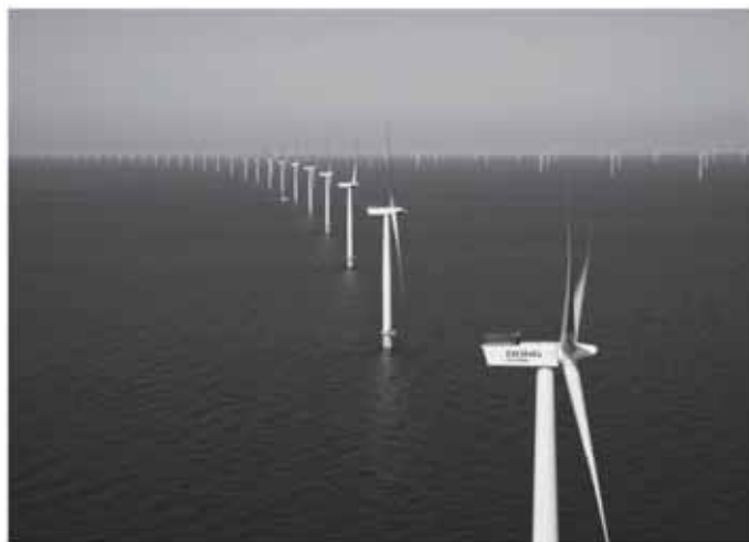
Photo d'un parc éolien en mer - Crédit : Siemens
