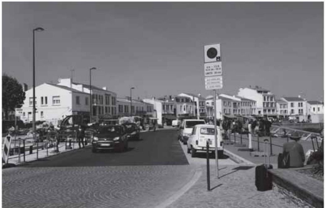
Les travaux du front de port se poursuivent
