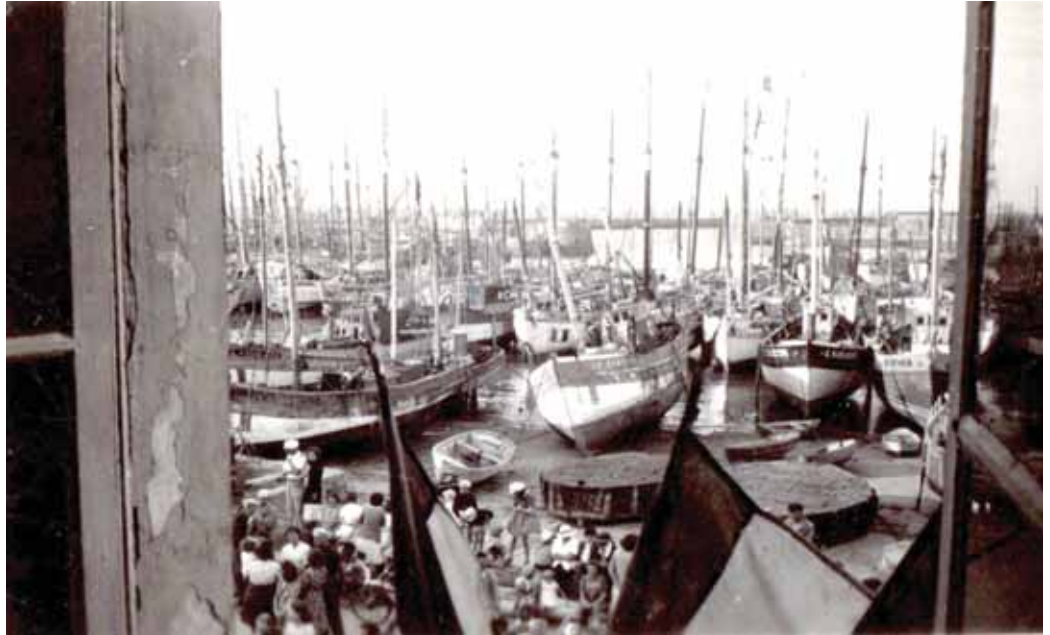
Photo prise par Marcel Vallée, depuis la salle de la mairie, le jour de la libération de l'île ou lors de la réception des Canadiens. On remarque la foule sur le quai et des drapeaux sur la façade de la mairie. Coll. Mme Vaquelin-Vallée.
