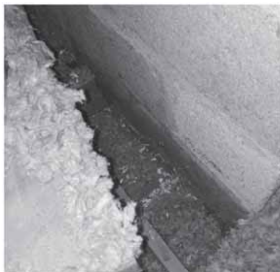
Il arrive que l'isolant ne soit pas appliqué sur toute la surface du plafond (Crédit : EIE 85)
