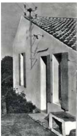
Les premiers branchements 4 fils sur les maisons individuelles. Revue des applications de l'électricité N° 181 – avril 1958
