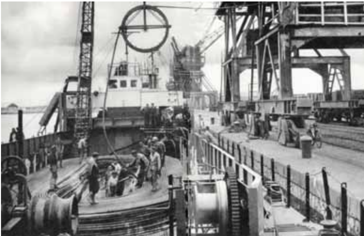
Sur les quais de Calais, le câble s'enroule à bord du Landing Craft Tank américain. Revue des applications de l'électricité N° 181 – avril 1958.
