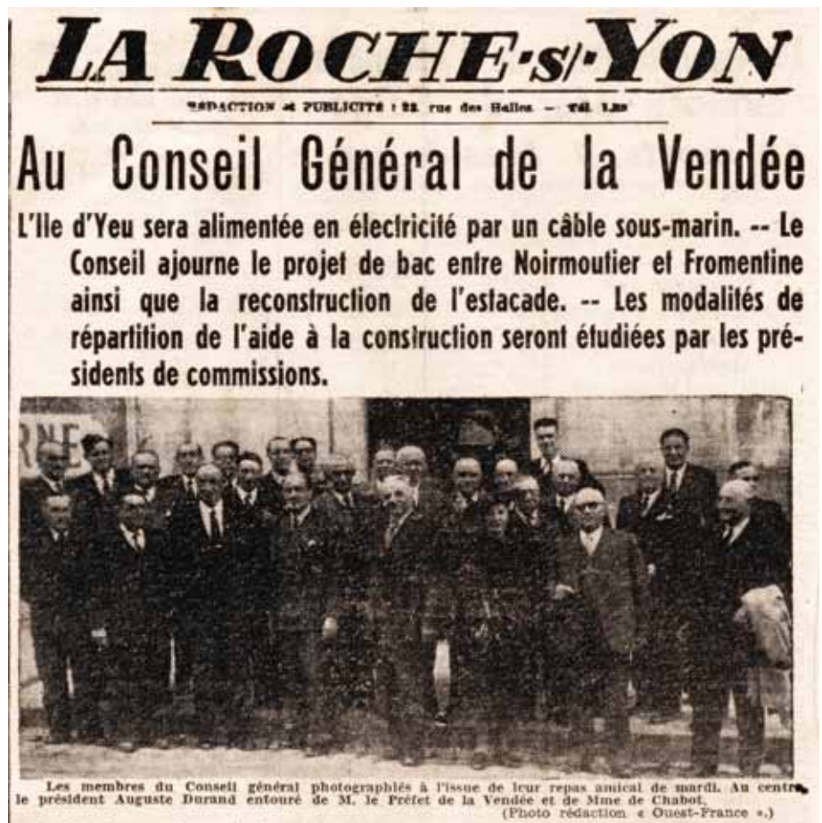
Le Conseil général de la Vendée approuve la décision de la Commune de l'île d'Yeu de choisir le câble sous-marin. Ouest-France – 25 septembre 1952.
