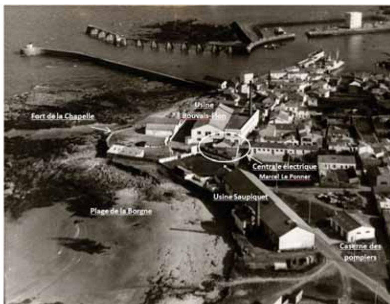
La centrale électrique de Marcel Le Ponner se situait dans le quartier des usines qui pouvaient bénéficier de cette nouvelle source d'énergie. Carte postale Coll. Jeanlin Henry
