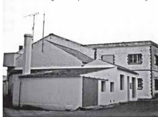
La centrale électrique de Marcel Le Ponner. Au second plan, l'usine de conserveries Bouvais-Flon. Cliché Service municipal du Patrimoine.
