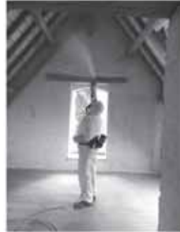
Traitement curatif et préventif
