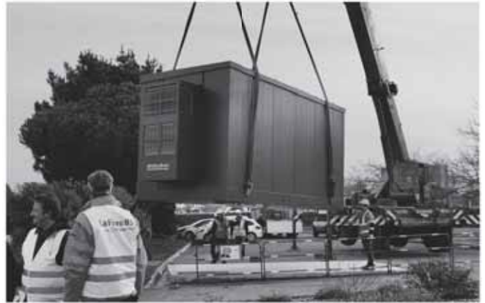
Installation du shelter sur le parking du cimetière de Port-Joinville
