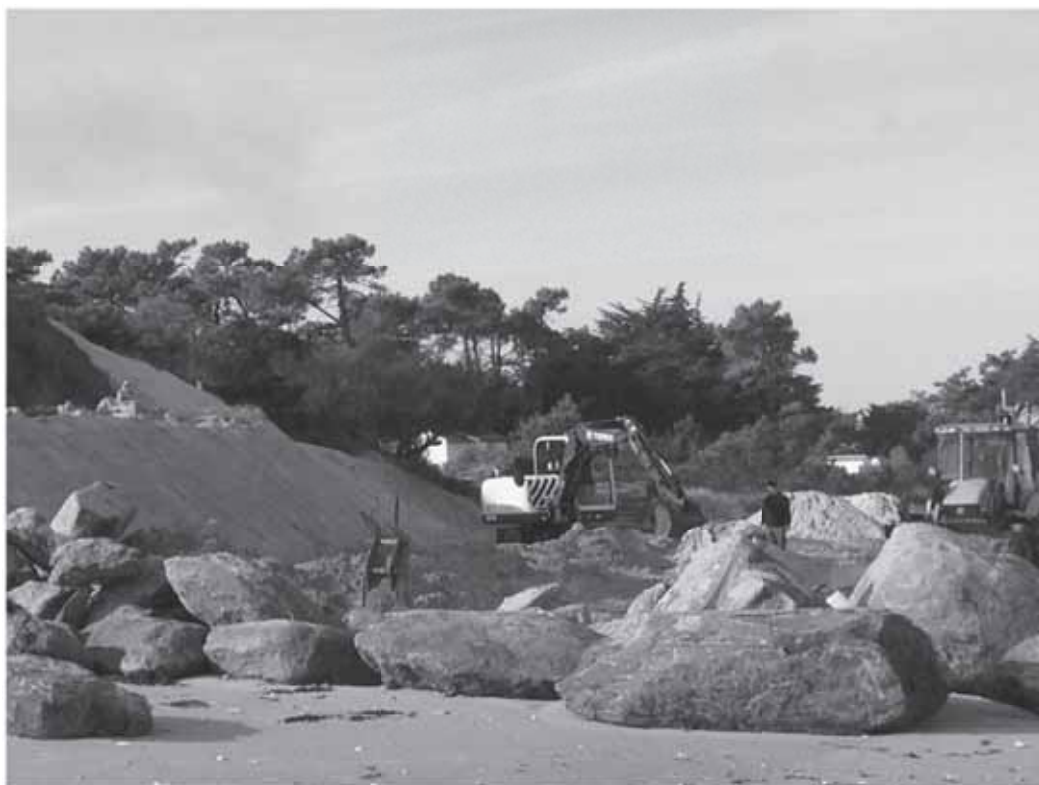
Travaux de consolidation réalisés en 2015
